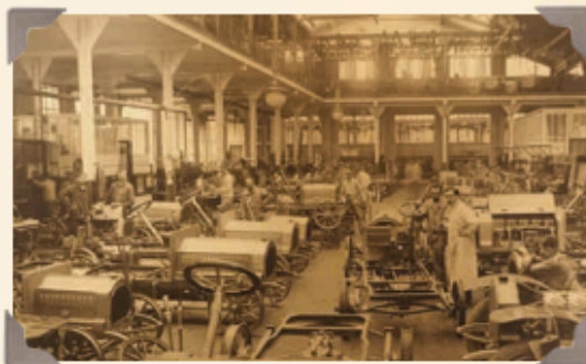
Construction en série de véhicules dans l'usine de Puteaux, photographie, env. 1910, AMP 421.
