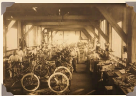
Construction en série de deux-roues dans l'usine de Puteaux, photographie, env. 1910, AMP 421.
